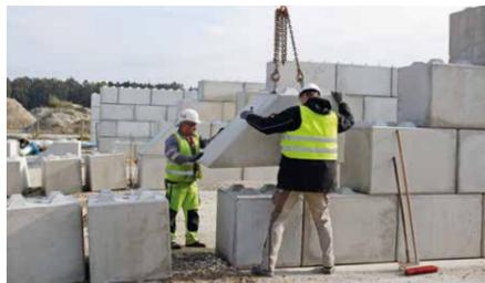
**BETONBLOXX® bilden ein modulares Wandsystem, das in kürzester Zeit aufgestellt und auch wieder abgebaut werden kann.**
