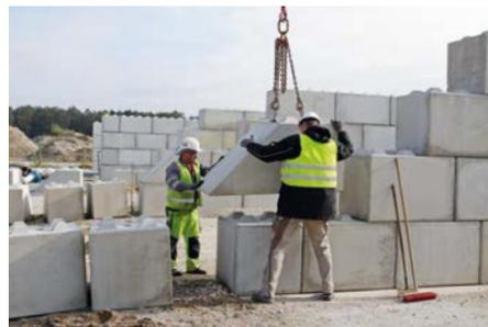
**BETONBLOXX® bilden ein modulares Wandsystem, das in kürzester Zeit aufgestellt und auch wieder abgebaut werden kann.**
